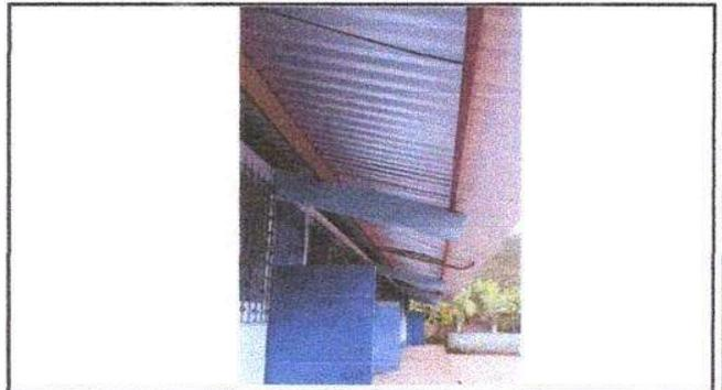
Foto 4: Lámina por lámina troquelada aluzinc calibre 26 sustiuda por la anterior
