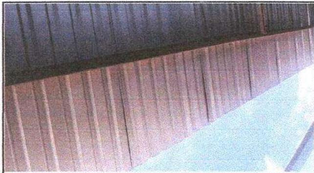
Foto 3: Lámina por lámina troquelada aluzinc calibre 26 sustiuda por la anterior
