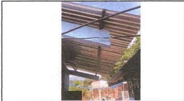
Foto 1: Lámina por lámina troquelada aluzinc calibre 26 sustiuda por la anterior
